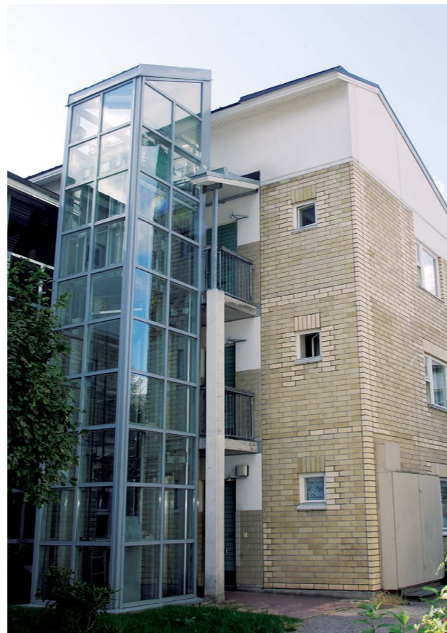
Installazione tipica di un ascensore esterno all'edificio, in castelletto metallico con tamponamento in cristallo trasparente
