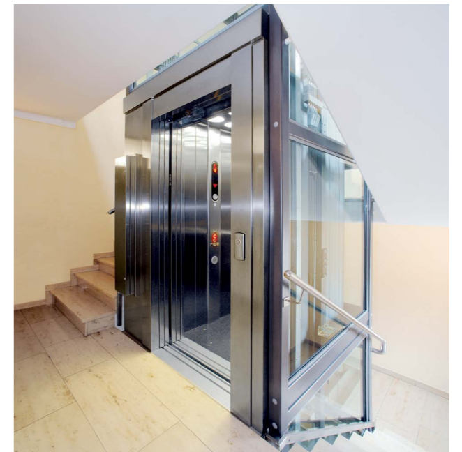
Installazione tipica di un ascensore interno all'edificio, nel vano scala, in castelletto metallico con tamponamento in cristallo trasparente e acciaio inox
