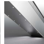
Illuminazione a faretti LED a soffitto
