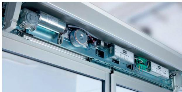
*Grazie al metodo di montaggio plug-and-play, KONE UniDrive® Retrofit può essere installato velocemente, con minime interruzioni di servizio e senza modifiche alla porta esistente.*
